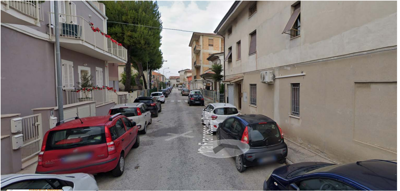
FOTO 1 ( DIREZIONE SUD - NORD)
